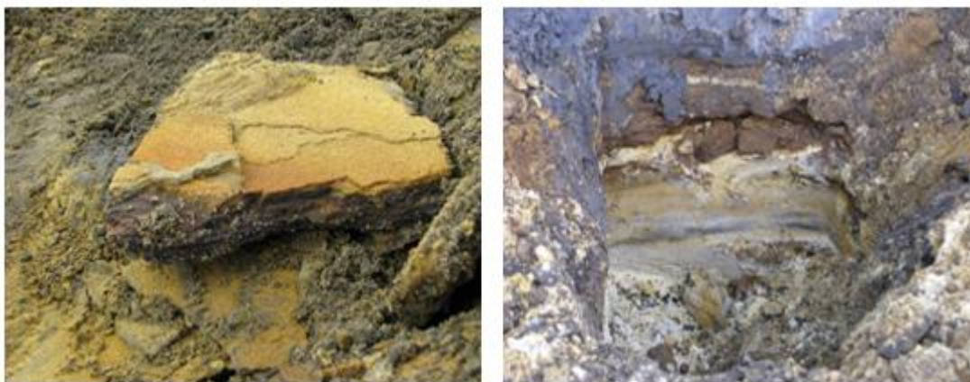
Fig.3.1.3 Imagini ale stratului cimentat prezent în substratul steril ce constituie corpul iazului de decantare
