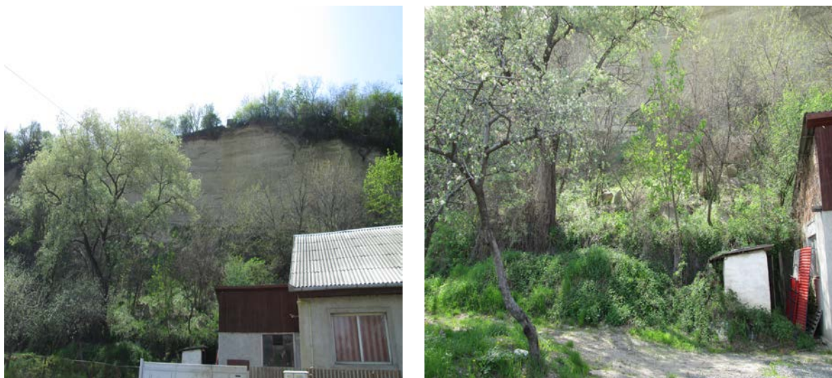
Figura 3.38, 3.39 – Alunecare de teren în zona sud-vestică a Dealului Gării
