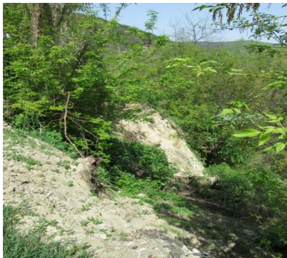
Figura 3.30 – Alunecare de teren pe malul stâng al pârâului Saeș
