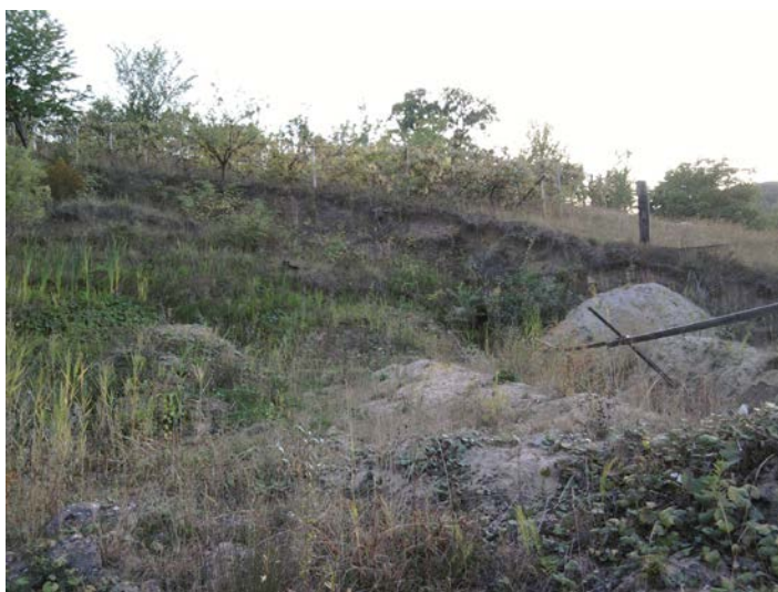
Figura 3.46 - Versant alcătuit nisipuri și nisipuri argiloase afectat de alunecări de teren pe str. Cânepii
