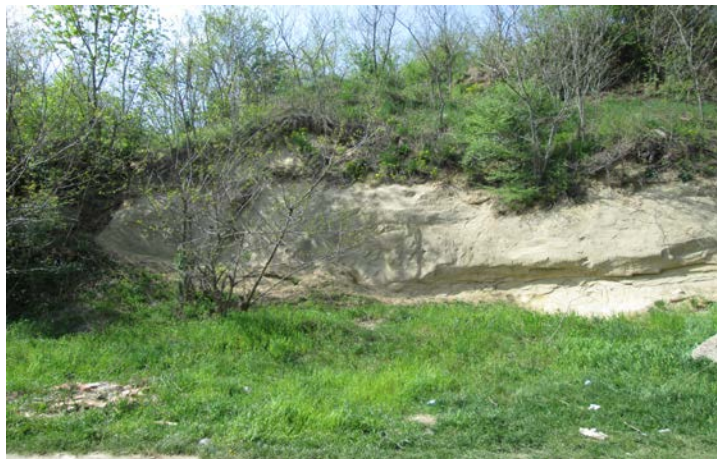
Figura 3.40– Alunecare de teren în zona sud-vestică a Dealului Gării
