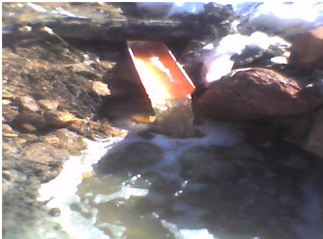
Fig.nr.32 Exfiltrațiile din digul aval de barajul principal iaz Valea Straja (VSAR 2)
