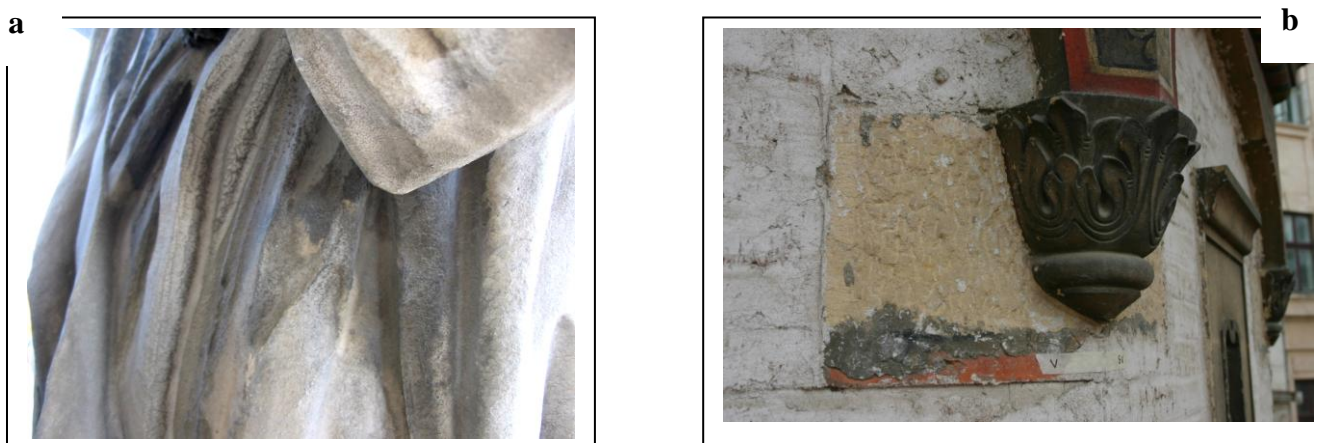
Fig. 1. Crustă neagră pe suport de (a) marmură (statuie pe fațada principală a Palatului de Justiție, București, 2004) și (b) de calcar (capitel W-SW, biserica Stavropoleos, București, 2009).
