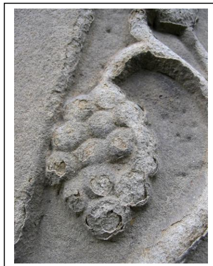
Fig. 5. Vezicularea locală a stratului superficial din gresie. Coloană pridvor, biserica Fundeniei Doamnei, București, 2006.
