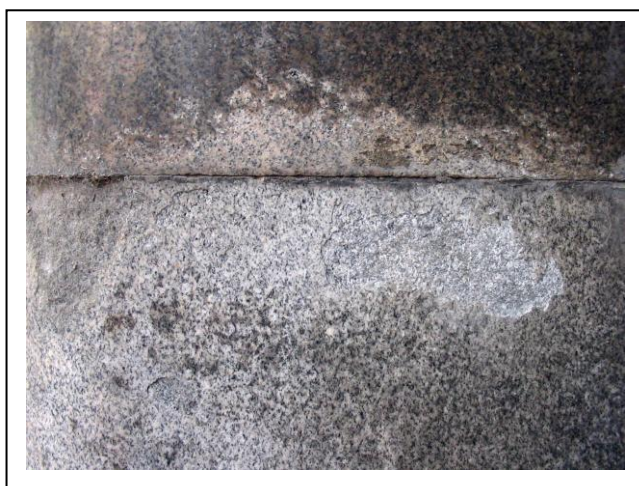
Fig. 1. Crustă neagră pe suport de (a) marmură (statuie pe fațada principală a Palatului de Justiție, București, 2004) și (b) de calcar (capitel W-SW, biserica Stavropoleos, București, 2009).
