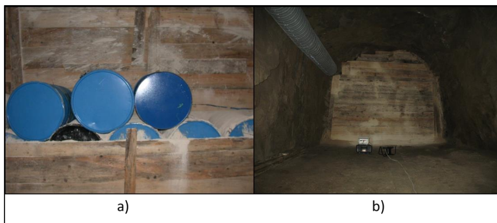
Figură 10. Modalitatea de aranjare a coletelor condiționate cu deșeuri radioactive împreună cu bentonita și cofrajul de lemn:
