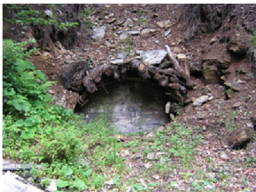
Fenomene de subsidență minieră sau colaps
