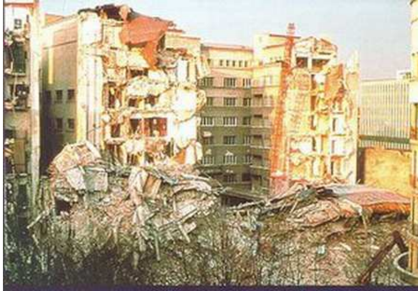
Fig. 1 - București, 4 martie 1977; consecințe ale unui cutremur cu magnitudinea M_w=7.4 .
